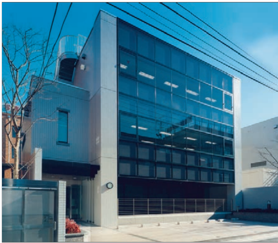
YDM日暮里ビル外観
